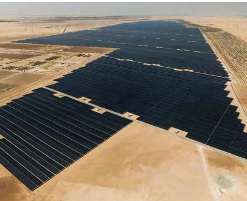
Cánh đồng điện mặt trời lớn nhất UAE
