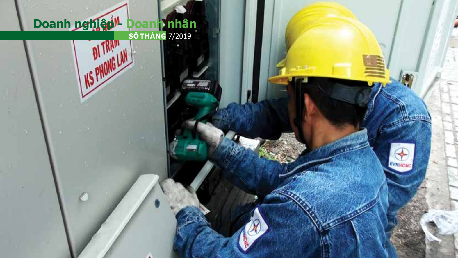
EVNHCMC sẽ hoàn tất 100% lắp đặt công tơ đo từ xa trong năm 2020.
