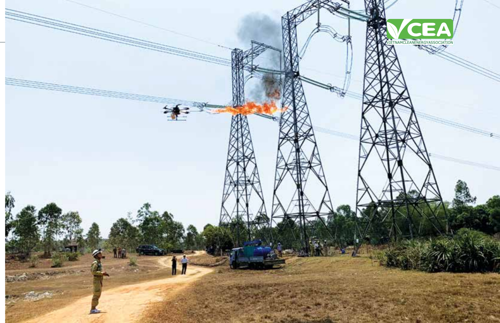
Ứng dụng thiết bị bay để đốt các vật thể mắc trên đường dây truyền tải đang mang điện.
