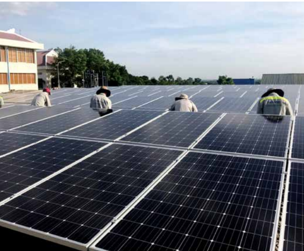
Hệ thống năng lượng mặt trời tại trụ sở Tổng công ty Điện lực TPHCM.
