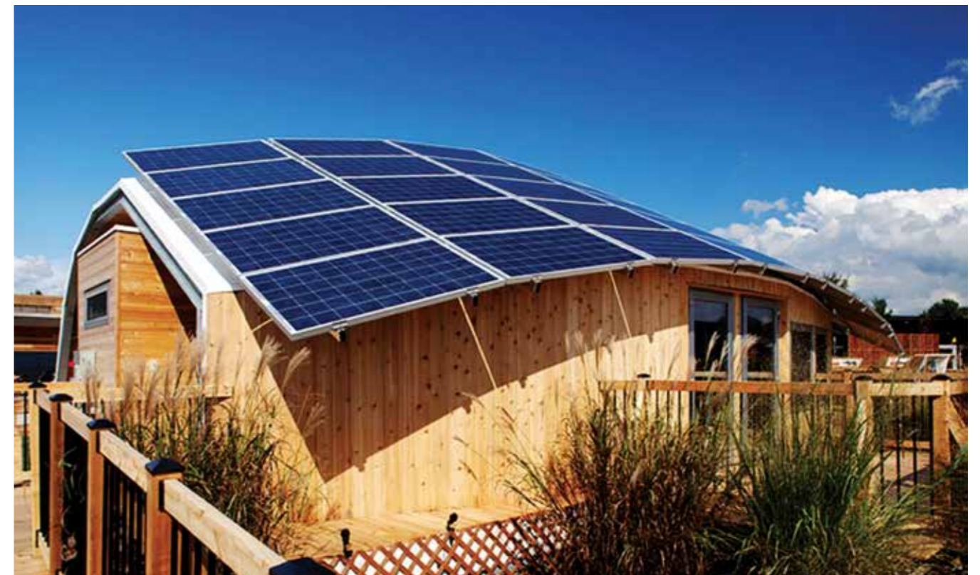
Hình 2. Dàn PMT công suất 2,8kWp (28 module x 100Wp/module) lắp trên mái nhà. Thấy rằng, các dàn PMT nghiêng một góc khoảng 25° so với mặt nằm ngang và đều hướng Nam.
