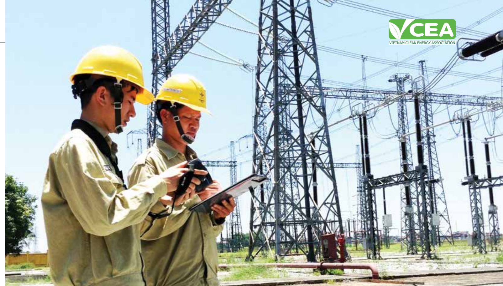
Nỗ lực đảm bảo điện cho các khu công nghiệp của EVNNPT góp phần quan trọng vào việc thu hút nguồn vốn đầu tư nước ngoài cho đất nước.
