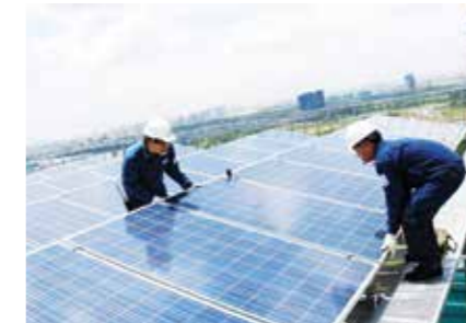
Điện mặt trời nổi lưới trên mái nhà góp phần làm giảm mức tiêu thụ năng lượng, tiết kiệm chi phí hoạt động của tòa nhà.
