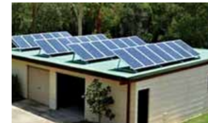
Hình 2. Dàn PMT công suất 2,8kWp (28 module x 100Wp/module) lắp trên mái nhà. Thấy rằng, các dàn PMT nghiêng một góc khoảng 25° so với mặt nằm ngang và đều hướng Nam.
