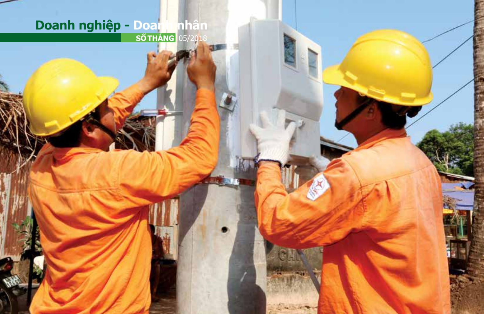
Năm nay, EVNSPC phân đấu đầu giảm thiểu hơn nữa sự cố lưới điện, nâng cao độ tin cậy cung cấp điện.
