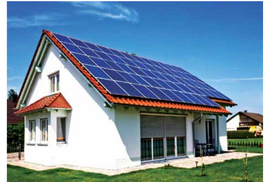
Hình ảnh về nguồn ĐMT có dàn PMT được lắp trên mái nhà.
