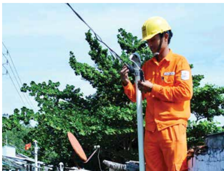
Lắp công tơ điện cho người dân ấp Bãi Chướng, xã Hòn Nghệ, huyện Kiên Lương, tỉnh Kiên Giang.
