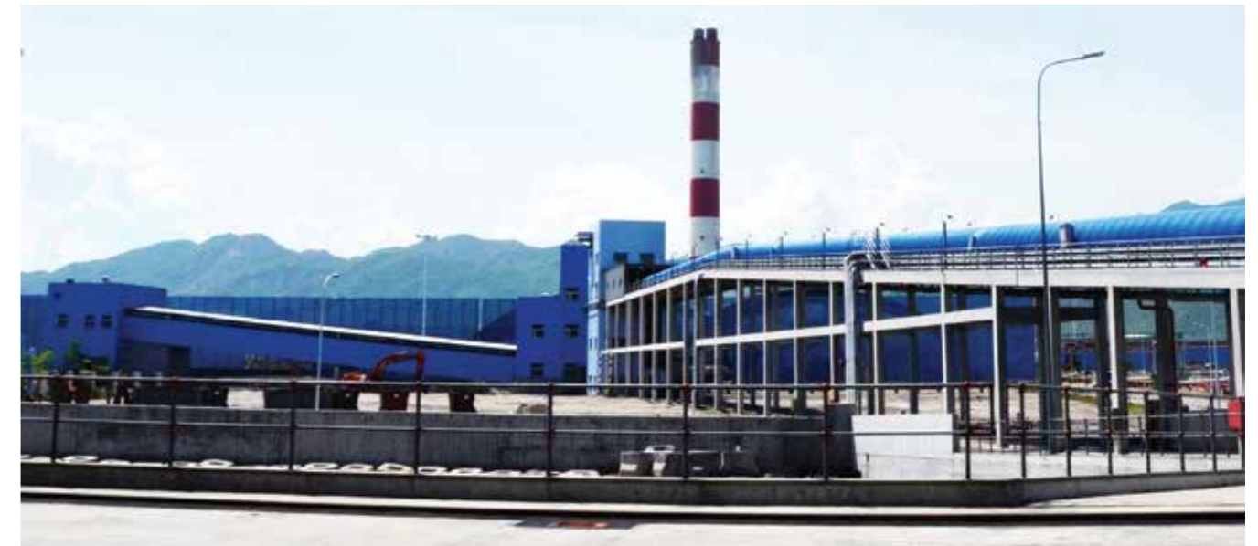
Nhà máy nhiệt điện Vĩnh Tân
