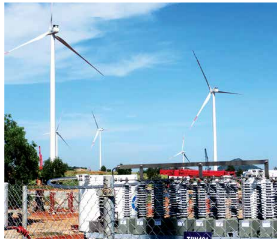
Nhà máy điện gió Phú Lạc đã đi vào hoạt động
