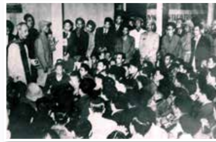
Ngày 21/12/1954 Bác Hồ đã tới thăm và nói chuyện động viên CBCN Nhà máy điện Yên Phụ và Nhà máy đèn Bờ Hồ
