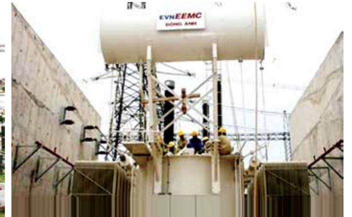
Tổ máy biến áp 500kV của EEMC
