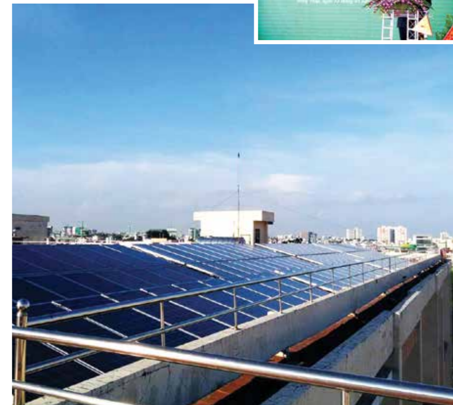
Nhà máy điện mặt trời Sao Mai 1
