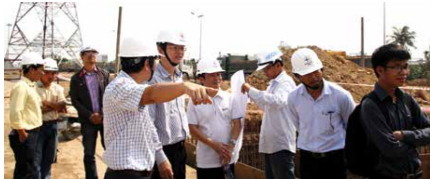
Tổng giám đốc EVNCPC Trần Đình Nhân thị sát việc thi công tuyến cáp ngầm 110kV thuộc dự án khôi phục đường dây 110kV từ TBA 500kV Đà Nẵng đến TBA 110kV Liên Trì phục vụ APEC 201
