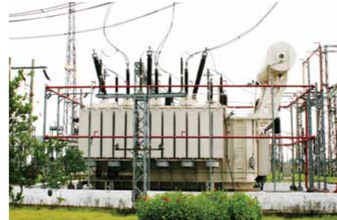
Tổ máy biến áp 500kV của EEMC
