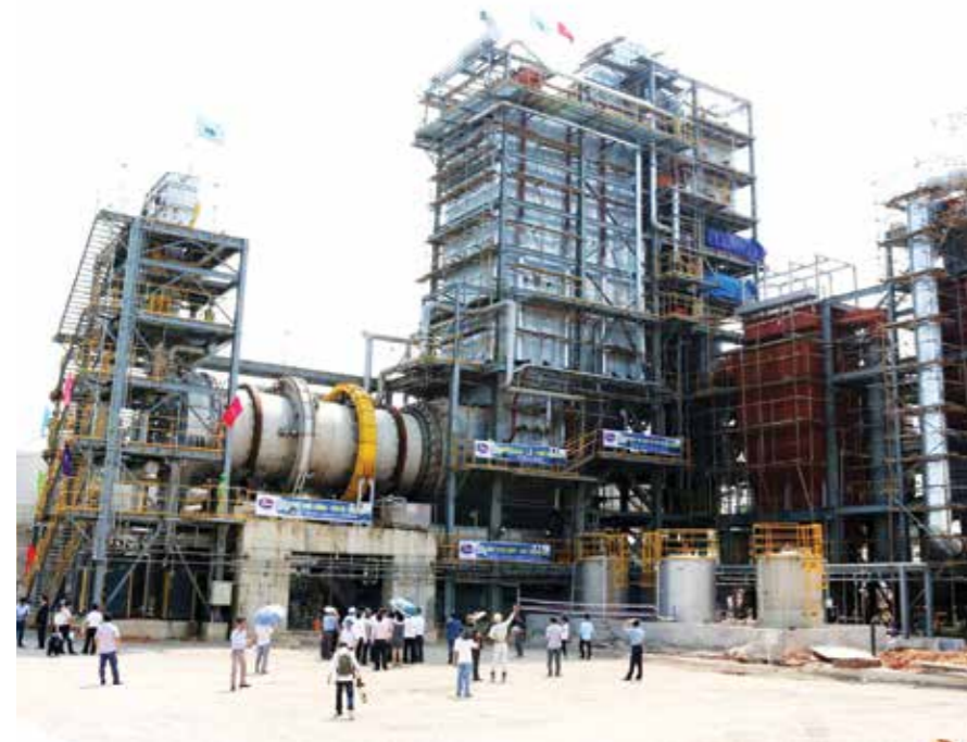
Nhà máy NEDO là nhà máy xử lý chất thải công nghiệp phát điện đầu tiên ở Việt Nam và khu vực
