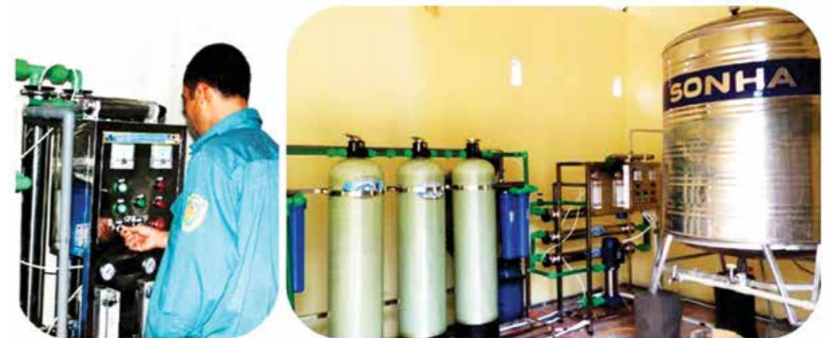
Hệ thống xử lý nước sạch tại xã Tư Mại, huyện Yên Dũng, Bắc Giang
