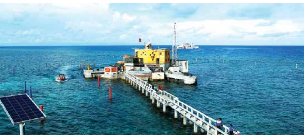
EVNSPC tiếp nhận, quản lý vận hành và đảm bảo cung cấp điện cho quần đảo Trường Sa và nhà giàn DK1.
