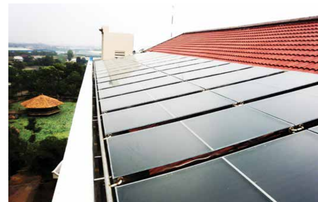
Trong năm 2018, EVNHCMC tiếp tục triển khai các công trình điện mặt trời nổi lưới tại tất cả trụ sở các công ty điện lực trực thuộc và các trạm điện 220, 110 kV.
