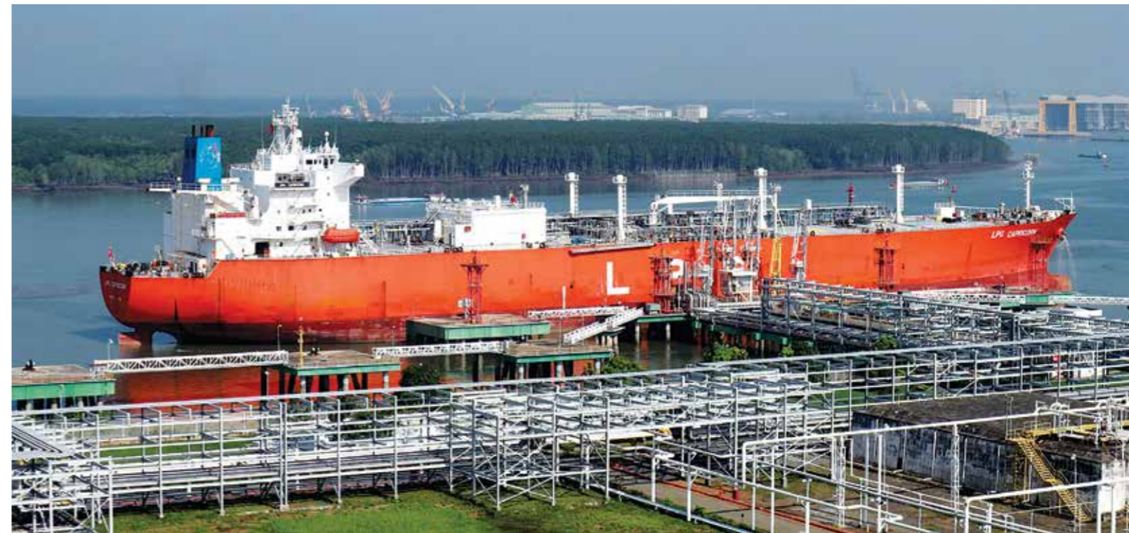
Dự án Kho chứa LPG lạnh tại Kho cảng PV GAS Vũng Tàu góp phần hoàn chỉnh hệ thống cơ sở hạ tầng ngành công nghiệp khí tại vùng kinh tế trọng điểm phía Nam.
