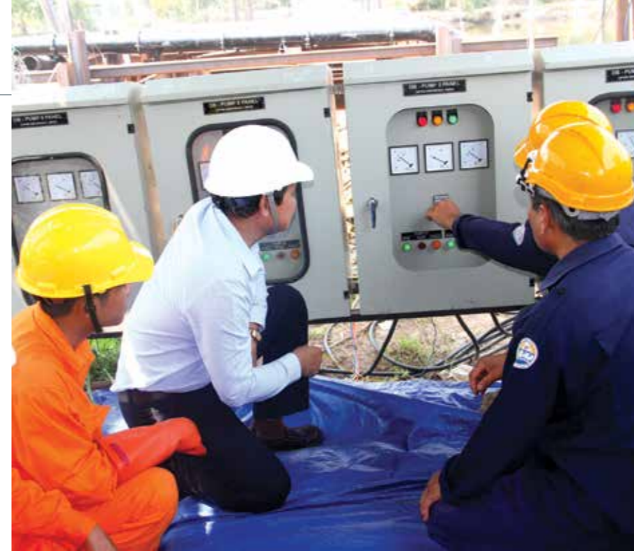
Đoàn EVNSPC kiểm tra hệ thống điện vận hành trạm bơm.
