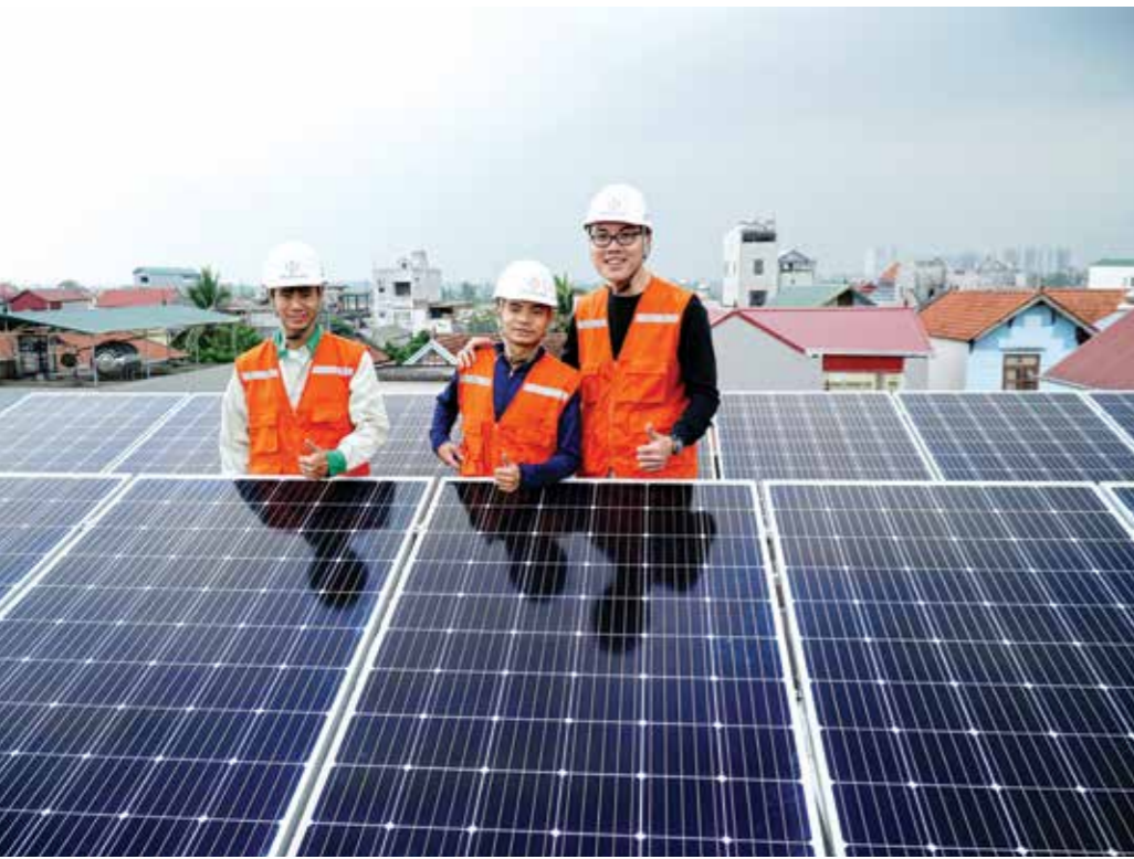
90 hộ gia đình lắp đặt điện mặt trời áp mái sẽ được hỗ trợ tiên
