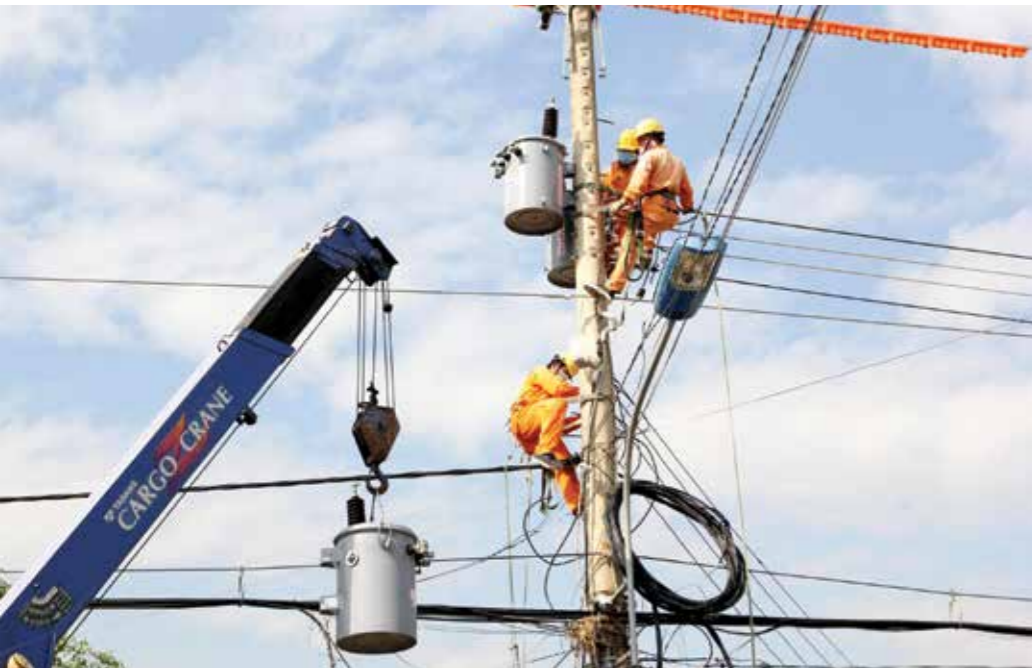
Lắp đặt trạm biến áp cấp điện cho 4 máy bơm phục vụ tưới nước chống hạn mặn trên địa bàn xã Bình Nghi, huyện Gò Công Đông, Tiền Giang.
