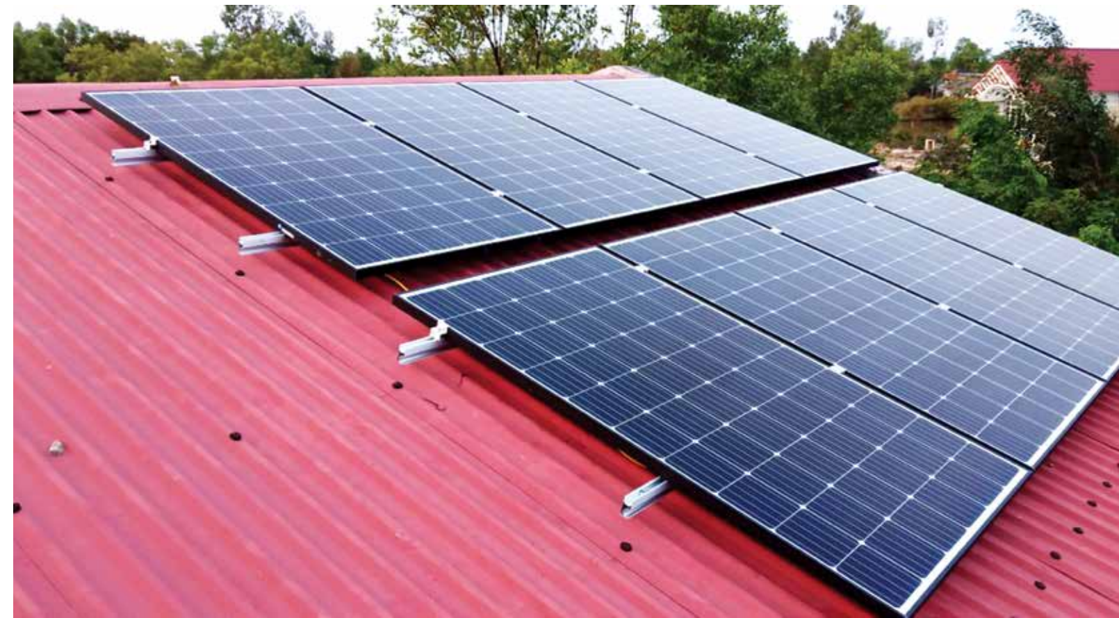
Hệ thống lọc nước RO bằng năng lượng mặt trời tại trường tiểu học Tân Hưng Đông 2, Cà Mau
