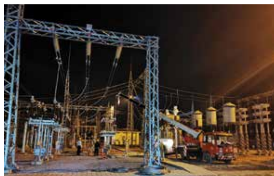
TBA Yên Bái được thi công cả vào ban đêm để kịp tiến độ.
