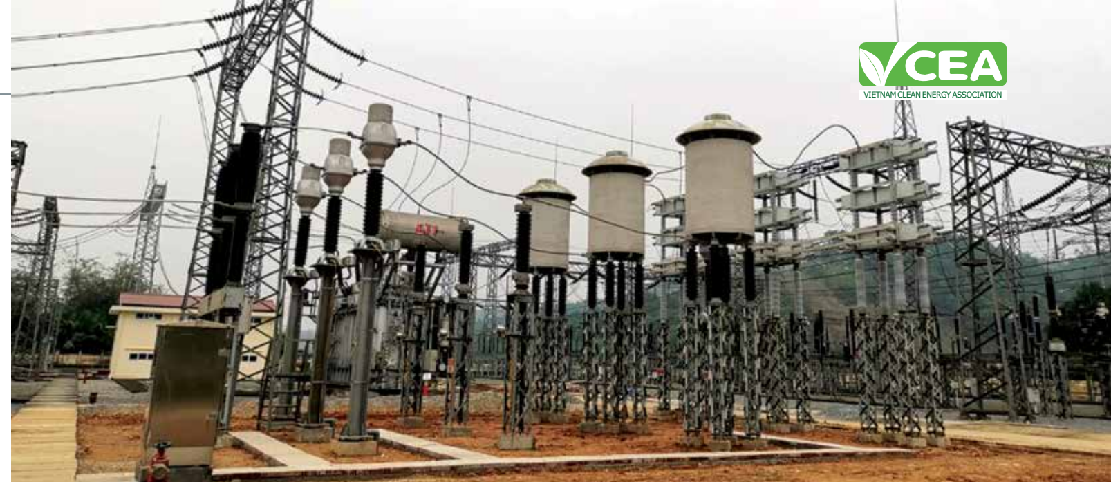
Công trình thi công lắp đặt giàn tụ bù ngang TBN101 - 25MVA tại TBA 220 kV Yên Bái đã hoàn thành đảm bảo an toàn, chất lượng, tiến độ.
