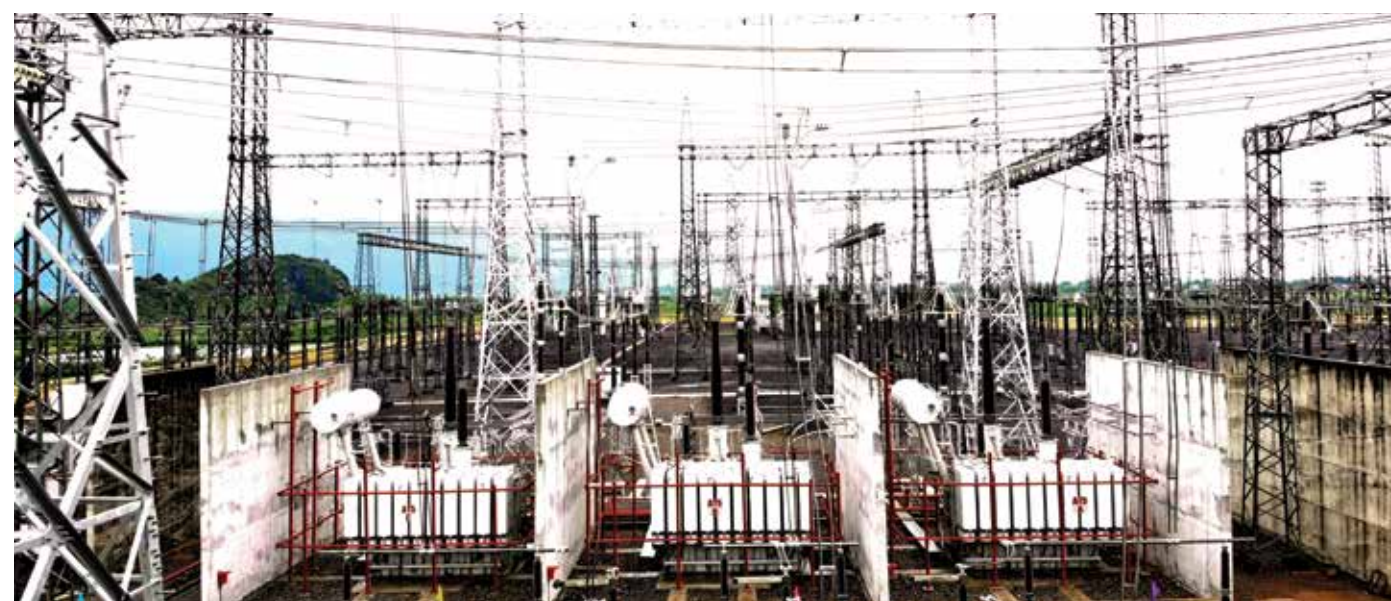
Đóng điện thành công tại TBA 500 kV Nho Quan.
