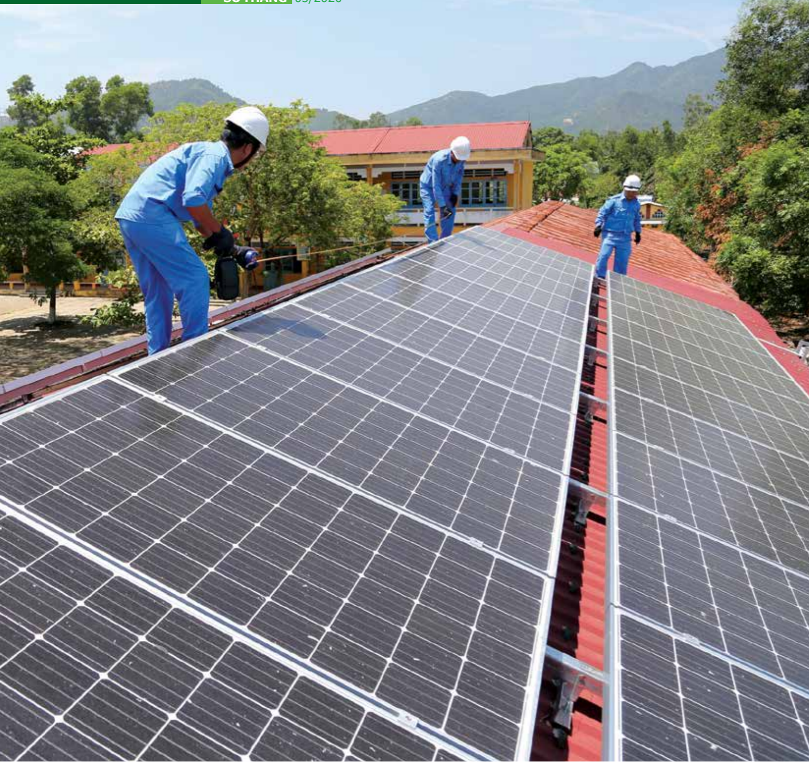
EVNCPC lắp đặt miễn phí hệ thống ĐMTAM cho trường học tại Quảng Nam.
