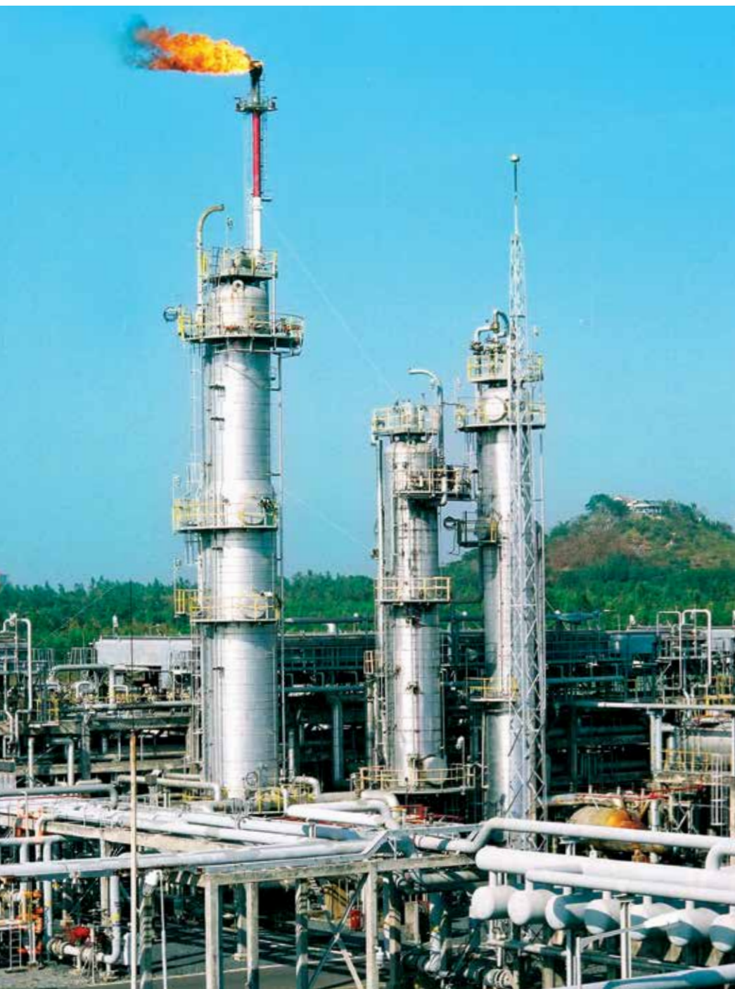
Nhà máy xử lý khí Dinh Cố.
