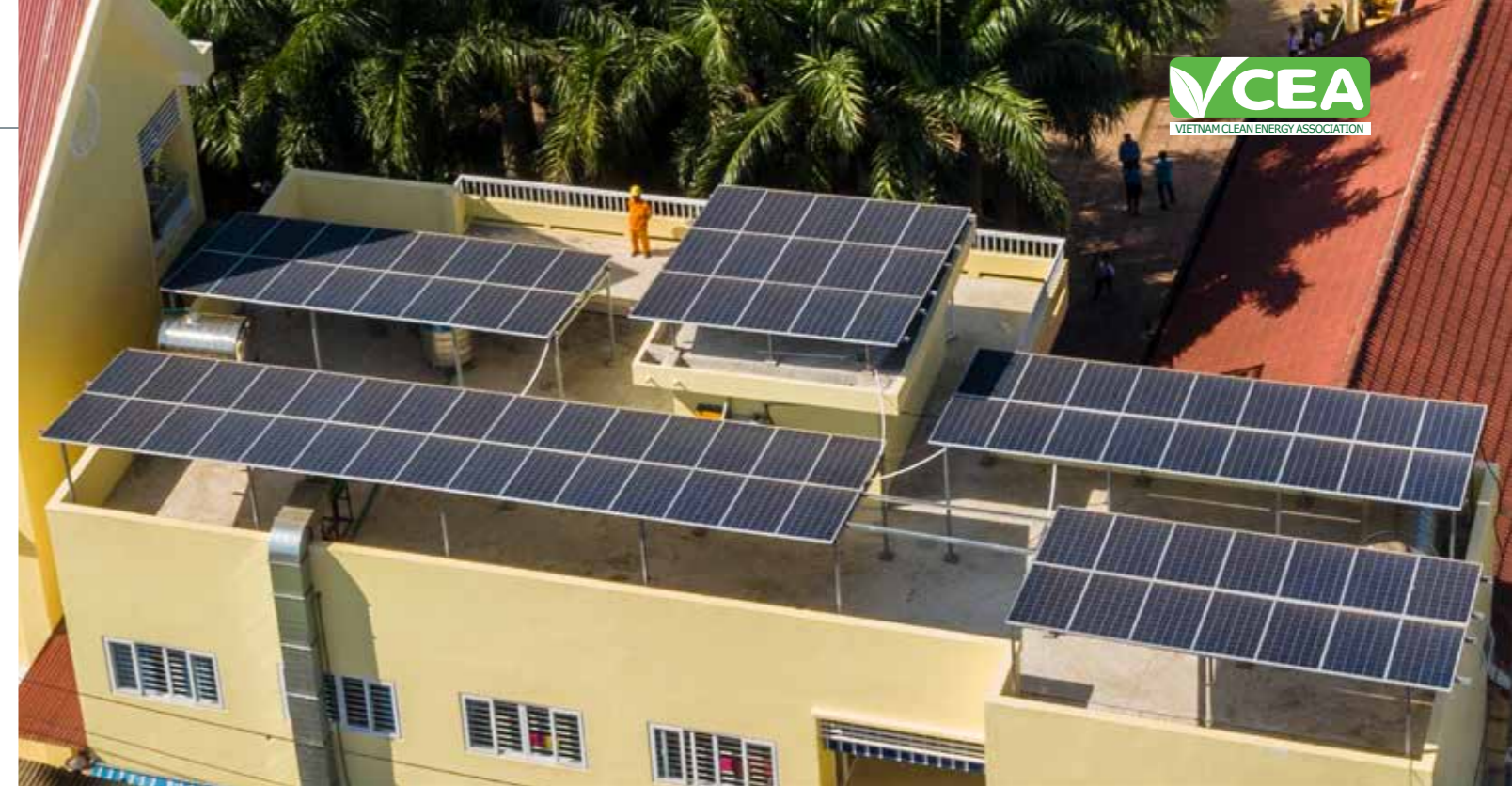
Một trường THCS tại Đắk Lắk tự đầu tư lắp đặt hệ thống ĐMTAM.
