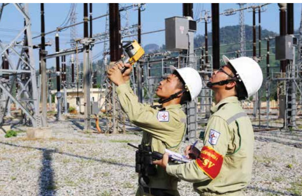
Kiểm tra phát nhiệt, ngăn ngừa sự cố TBA.
