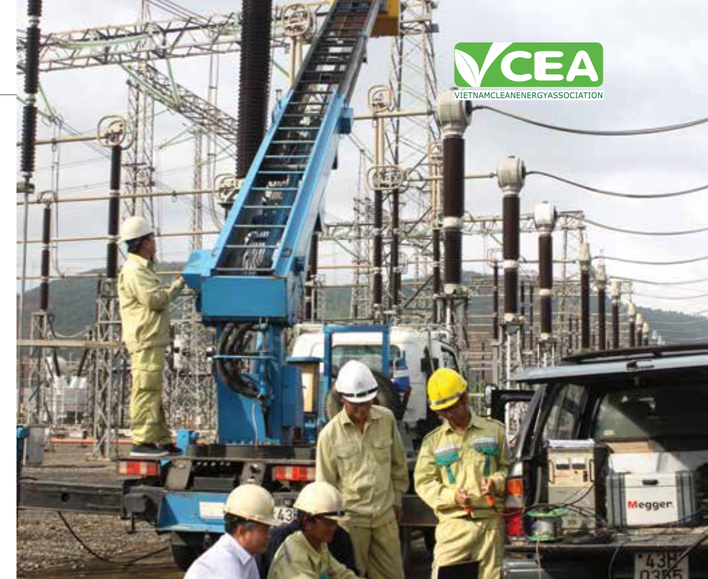
Thí nghiệm thiết bị tại TBA 500 kV Đà Nẵng
