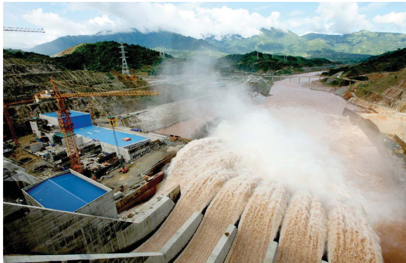
■ Đập tràn công trình Thủy điện Lai Châu
