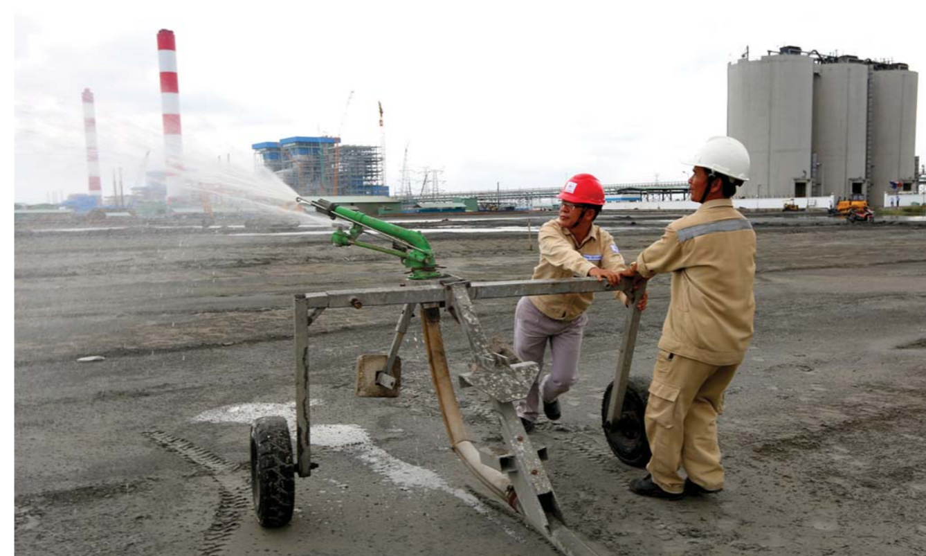
Hệ thống phun sương chống bụi tại khu vực chứa xỉ thải của nhà máy Nhiệt điện Duyên Hải
