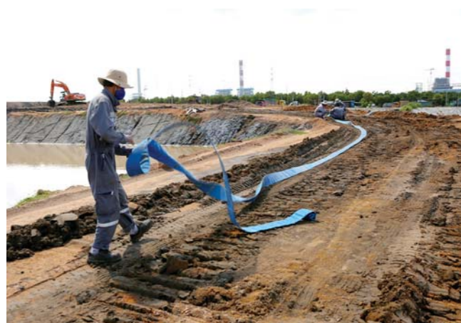
■ Lắp đặt hệ thống phun nước chống bụi tại khu vực chứa xỉ thải của nhà máy Nhiệt điện Vinh Tân
