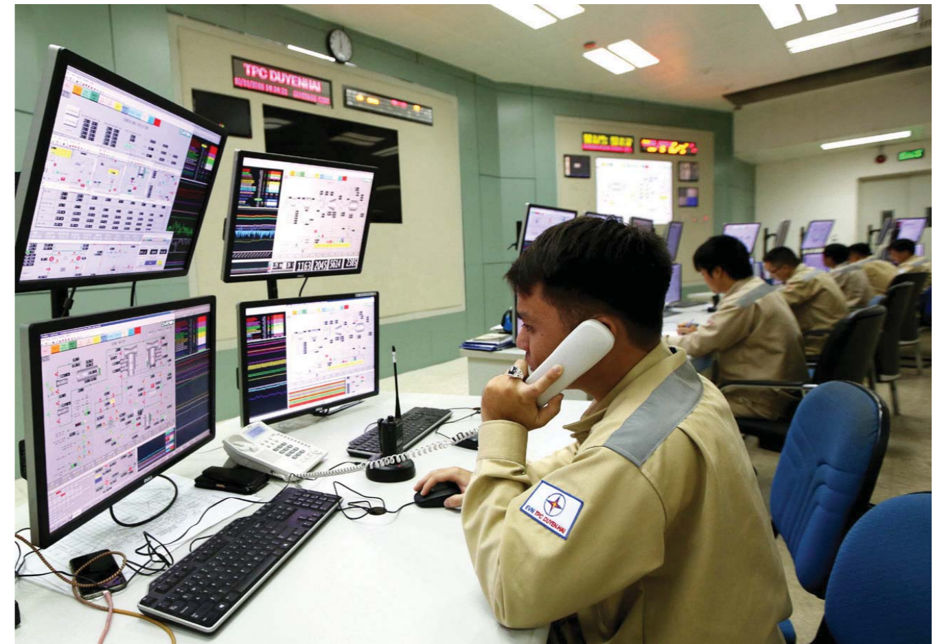
Màn hình hiển thị thông số kiểm soát khí thải tại nhà máy Nhiệt điện Duyên Hải
