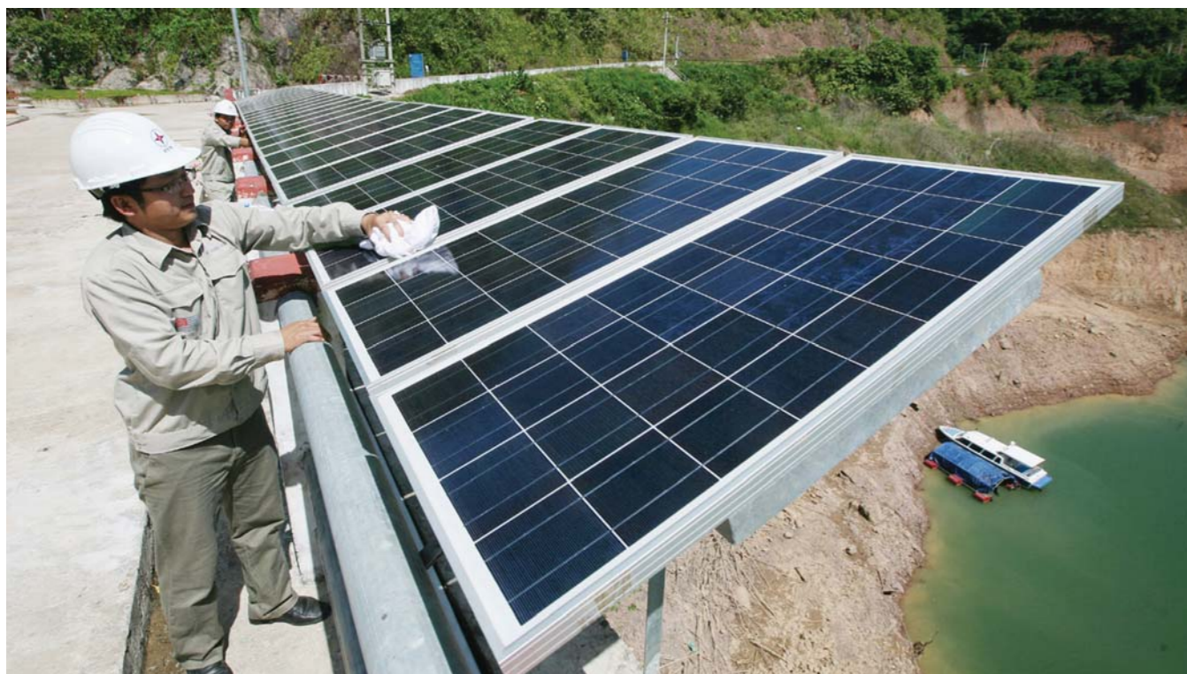
Hệ thống pin mặt trời cung cấp điện vận hành đập thủy điện A Vương
