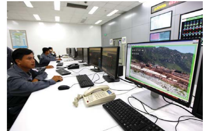
■ Hình ảnh và các thông số quan trắc từ khu vực bãi thải được truyền về trung tâm điều khiển Nhà máy nhiệt điện Vĩnh Tân
