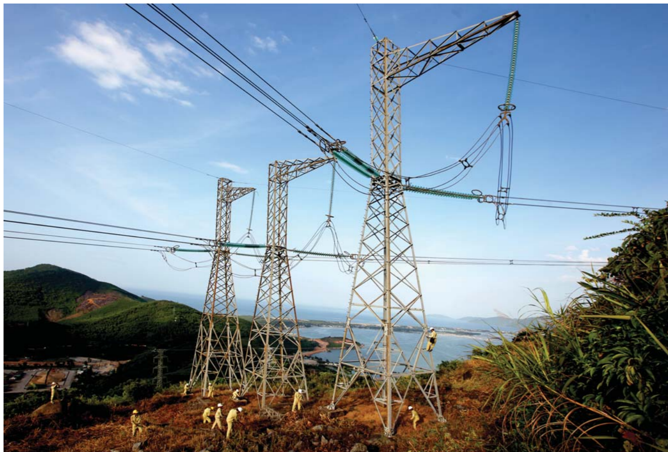
Đường dây 500kV Bắc Nam đoạn qua đèo Hải Vân
