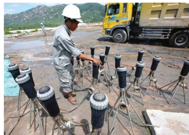
■ Lắp đặt hệ thống phun nước chống bụi tại khu vực chứa xỉ thải của nhà máy Nhiệt điện Vinh Tân
