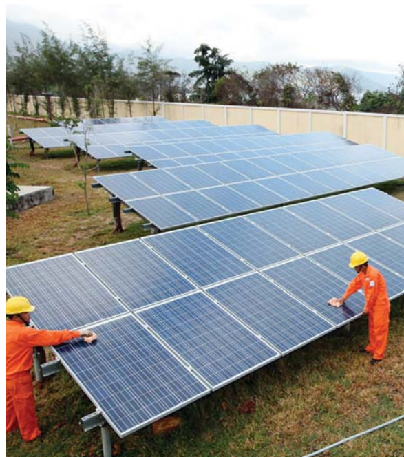
■ Nhà máy điện mặt trời do Điện lực Côn Đảo quản lý vận hành
