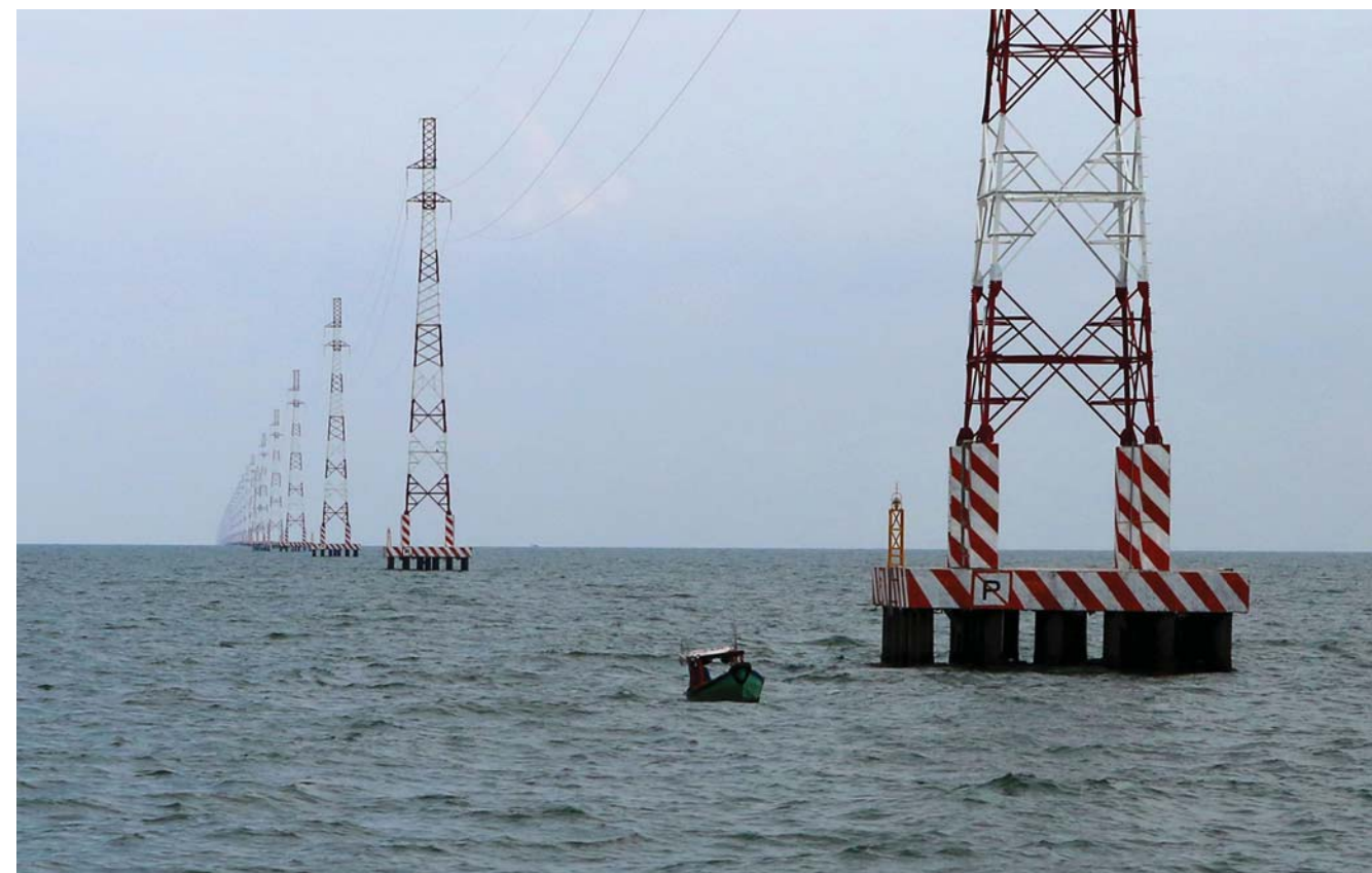
Đường dây 110kV vượt biển cấp điện cho xã đảo Lại Sơn
