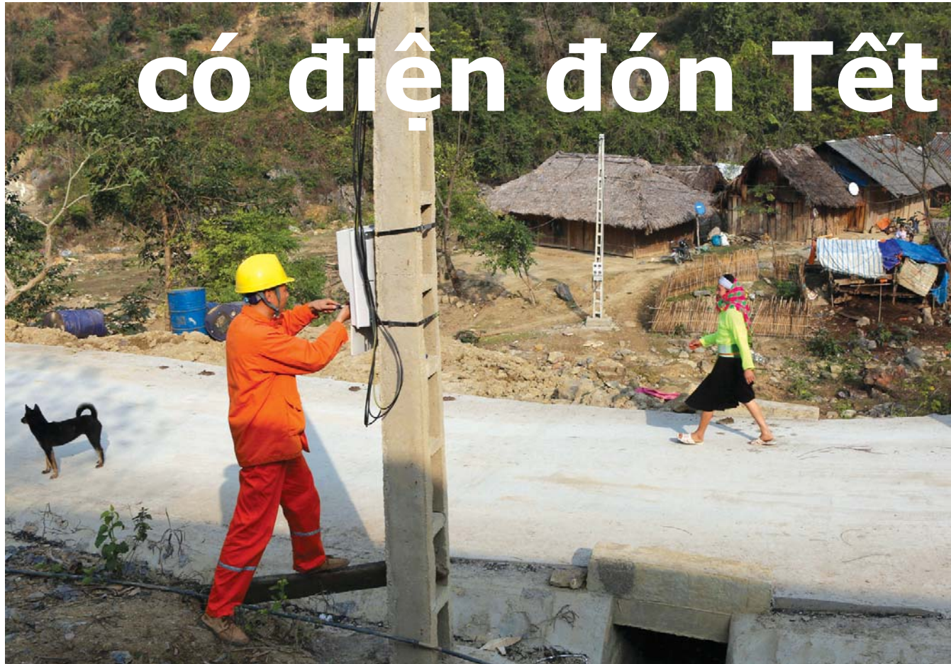
■ Công nhân Công ty Điện lực Thái Nguyên lắp đặt công tơ cung cấp điện cho người dân xã Văn Lăng
