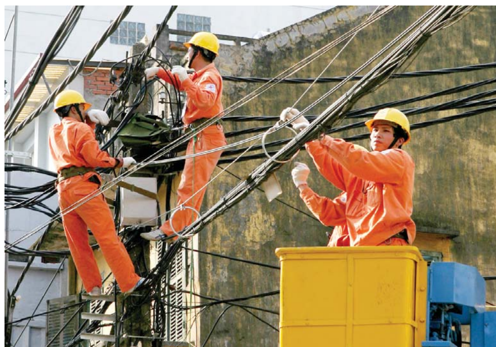
■ Công nhân Tổng công ty Điện lực Thành phố Hà Nội cải tạo lưới điện phân phối
