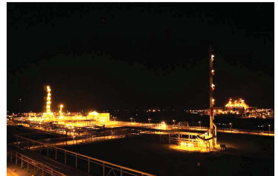
■ Công trường về đêm
