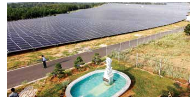
Nhà máy điện mặt trời Mũi Né
