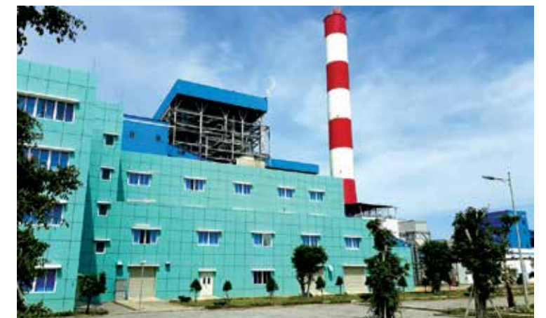
Nhà máy nhiệt điện Duyên Hải, Trà Vinh áp dụng công nghệ tiên tiến trong công nghệ xử lý môi trường.
