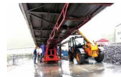
Hệ thống băng tải truyền tải phục vụ công tác đào lò mới của Than Nam Mẫu.
