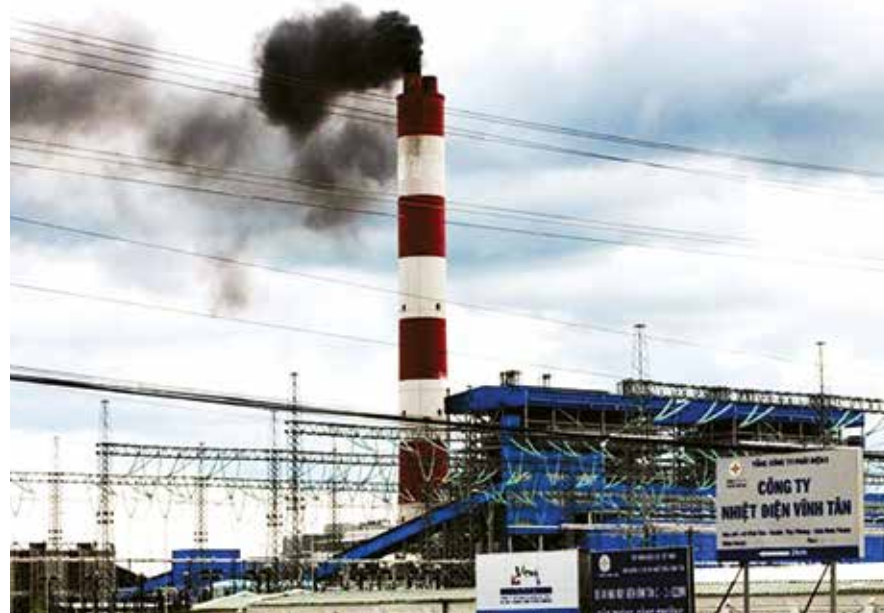
Nhà máy nhiệt điện Vĩnh Tân
