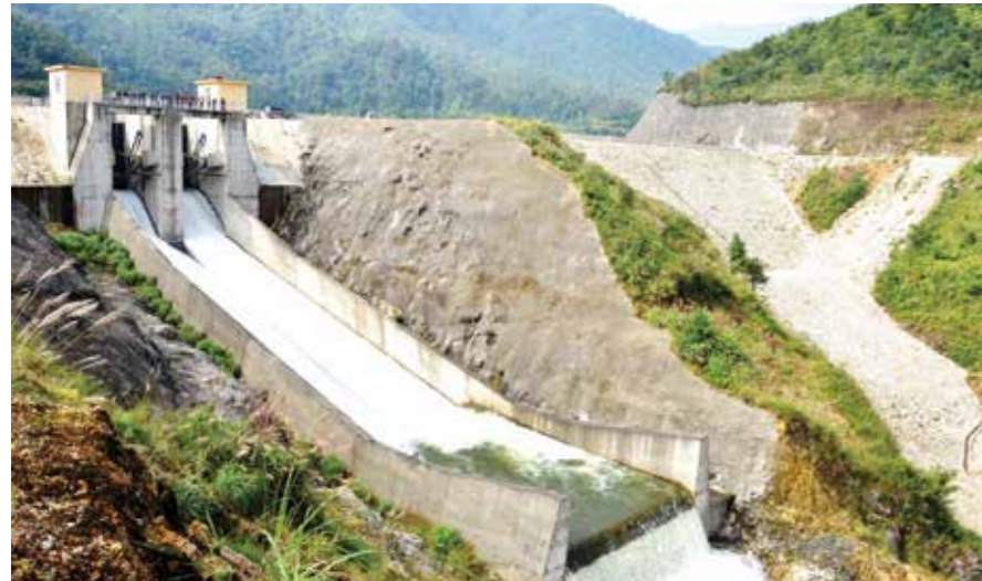
Một công trình thủy điện quy mô nhỏ.
