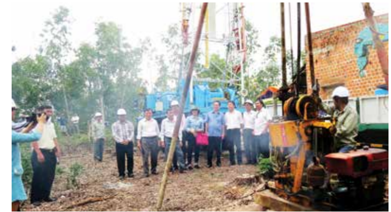
Khoan thăm dò dự án điện địa nhiệt Hội Vân
