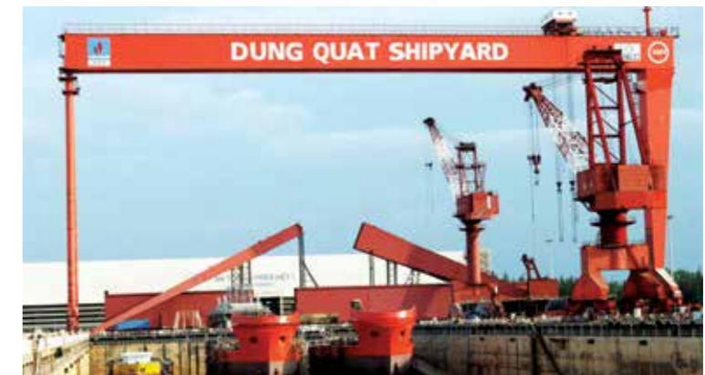
Dự án Nhà máy đóng tàu Dung Quất PVN đang chờ ý kiến chỉ đạo của cấp có thẩm quyền.
