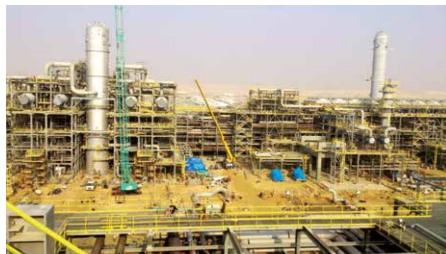
Nhà máy lọc hóa dầu Nghi Sơn đang trong quá trình xây dựng
