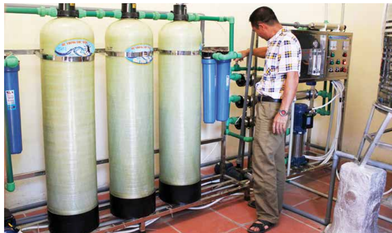
Hệ thống lọc nước uống tinh khiết công nghệ RO tích hợp sử dụng pin NLMT để giảm lượng điện năng.
