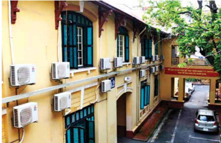
Bệnh viện Việt Đức thay mới toàn bộ điều hòa không khí giúp giảm được 518 tấn CO 2 mỗi năm.
