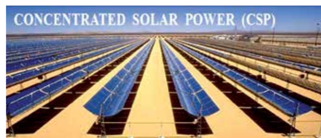
(3) Các máng gương parabol, CN NĐMT (CSP) (ảnh dưới)
