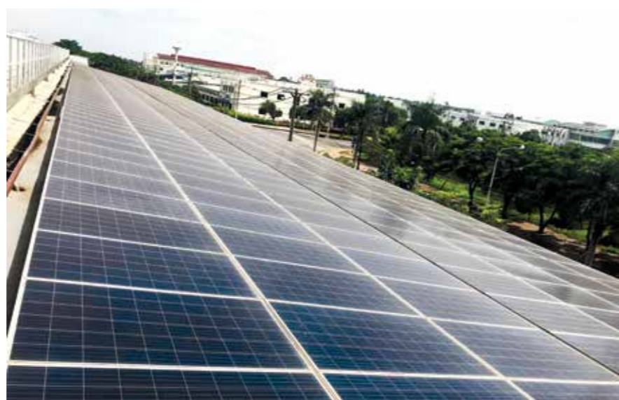
"Hệ thống pin năng lượng mặt trời tại nhà máy LiOA Electric Đồng Nai".
