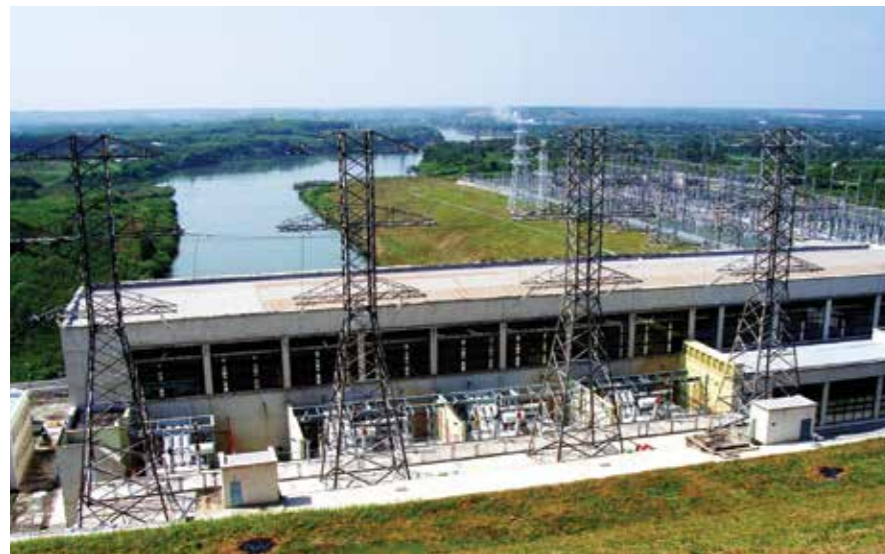
Thủy điện Trị An
