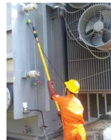
Nhân viên điện lực kiểm tra phóng điện cục bộ của MBA bằng công nghệ PD Testing.
