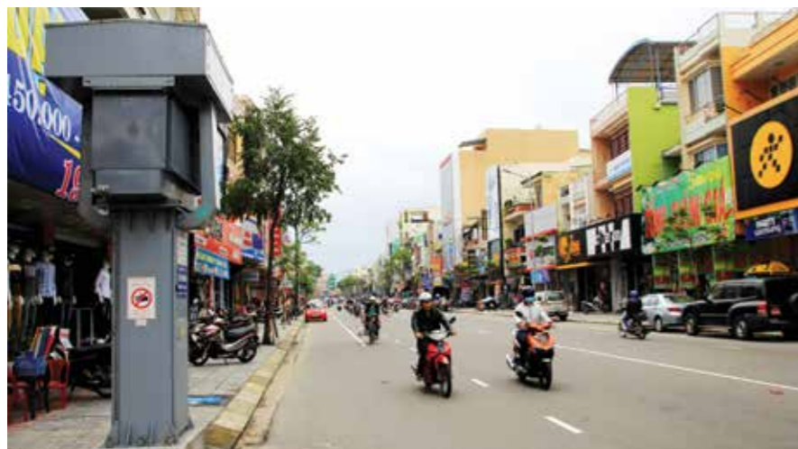
Ngầm hóa lưới điện trên tuyến phố Lê Duẩn (TP Đà Nẵng).
