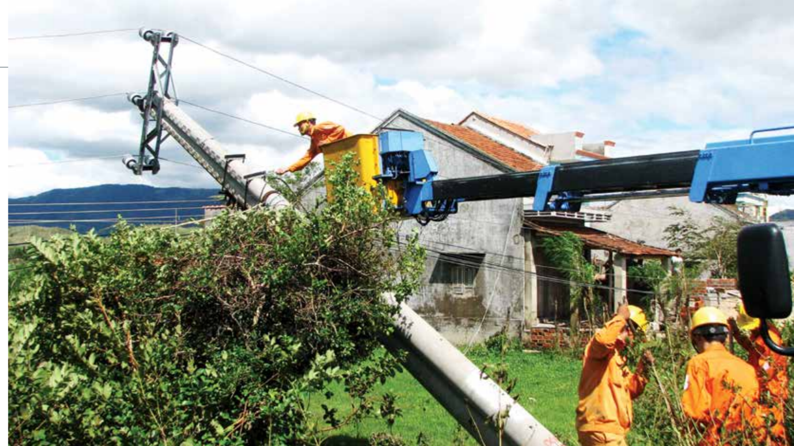
Trong mùa mưa bão, người dân dễ gặp phải khả năng mất an toàn do lưới điện gây ra.
