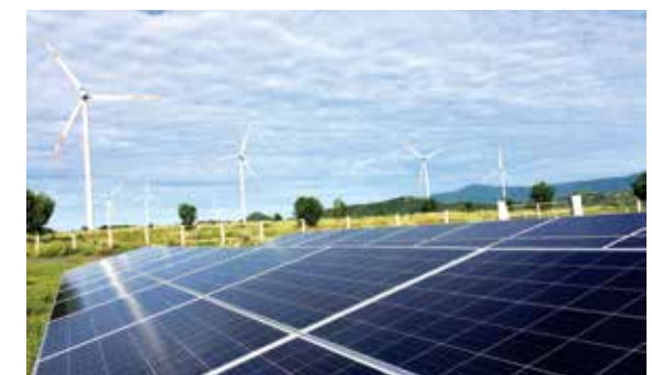
Nhà máy điện gió Bạc Liêu
