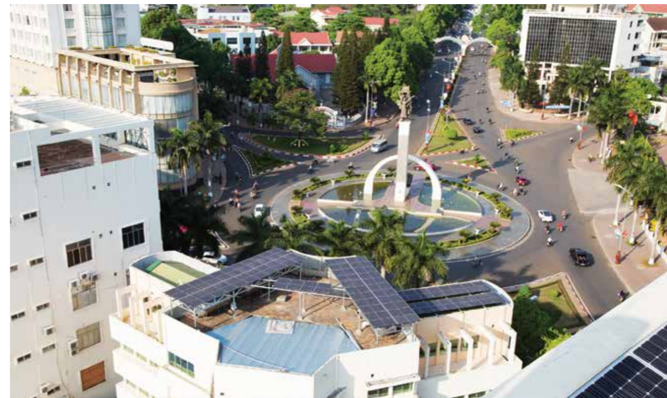
Trụ sở PC Buôn Ma Thuột lắp đặt hệ thống điện mặt trời áp mái
