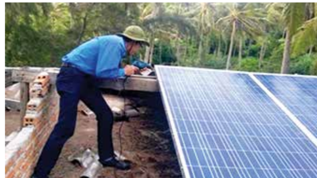
Hình 4: Lắp đặt thử nghiệm tấm pin mặt trời trên mái nhà sinh hoạt của bộ đội trên đảo Hòn Tranh, huyện đảo Phú Quý, tỉnh Bình Thuận (ngày 05/6/2017).
