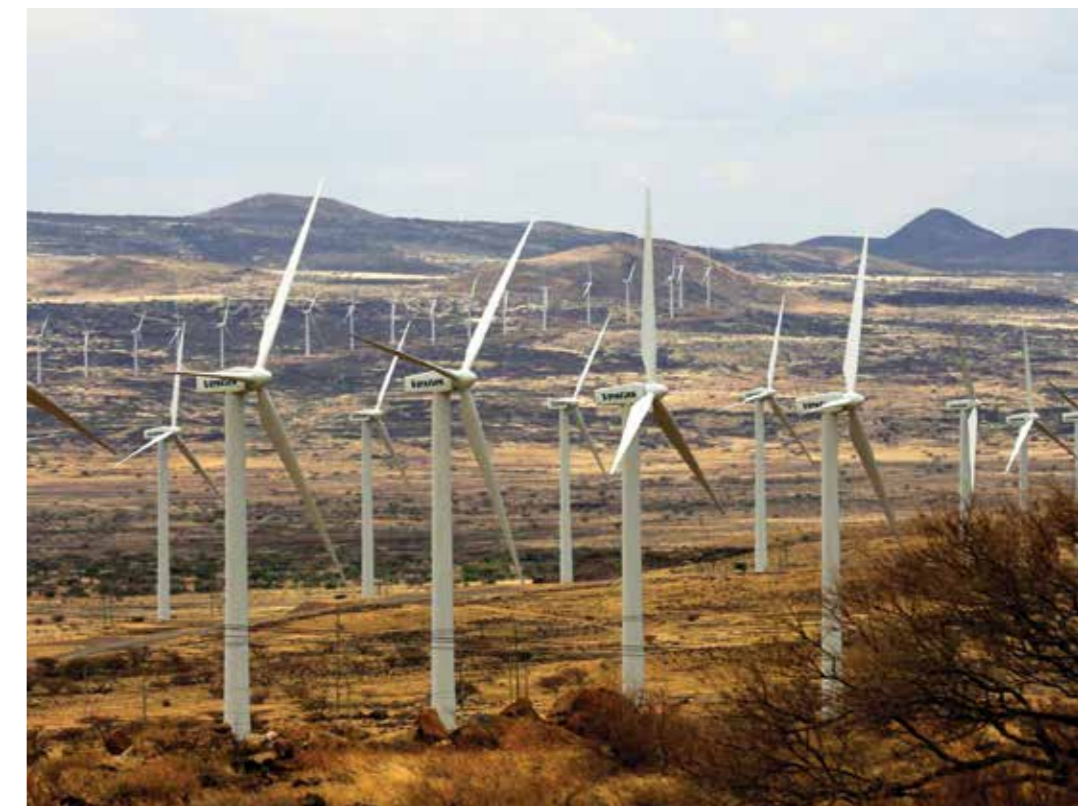
Trang trại điện gió Kenya lớn nhất khu vực châu Phi
