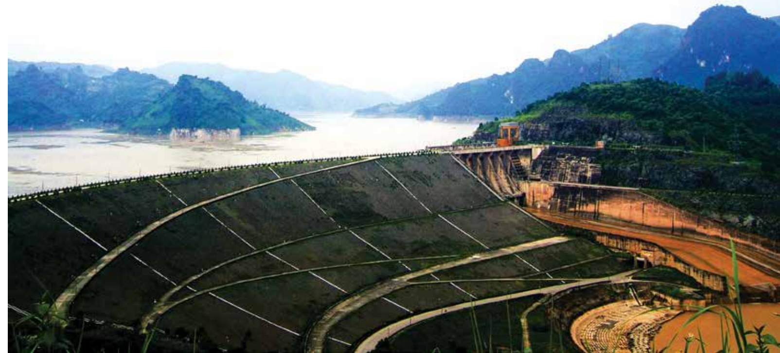
Trải qua 30 năm vận hành, Thủy điện Hòa Bình phát huy vai trò là công trình thủy điện chiến lược đa mục tiêu.
