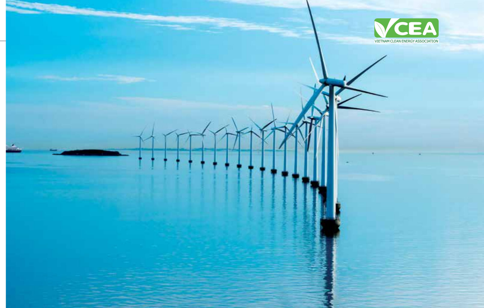
Dự án Kê Gà là một trong những dự án điện gió ngoài khơi có quy mô lớn hàng đầu thế giới hiện nay.
