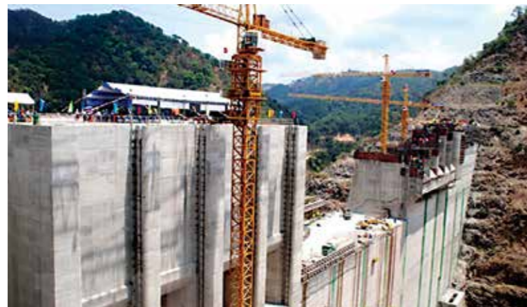
Dự án Thủy điện Xekaman 1 - một trong những công trình quan trọng thuộc chương trình hợp tác năng lượng giữa hai Chính phủ Việt Nam và Lào.
