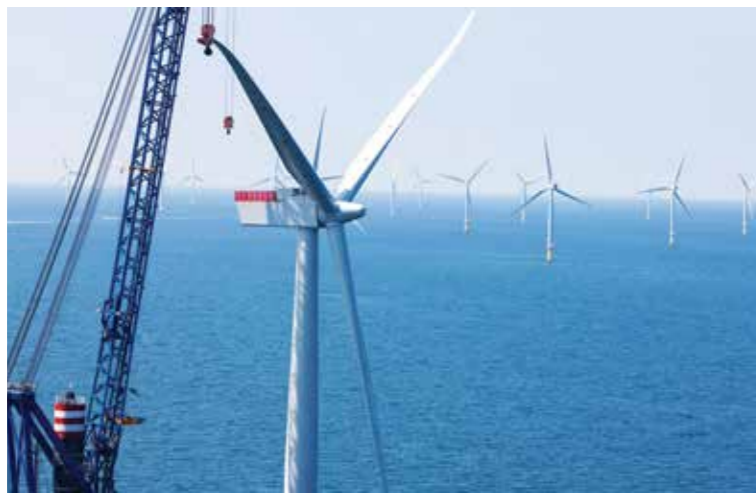
Những dự án điện gió ngoài khơi quy mô lớn sẽ góp phần giảm tải sự căng thẳng trong hệ thống điện của quốc gia.
