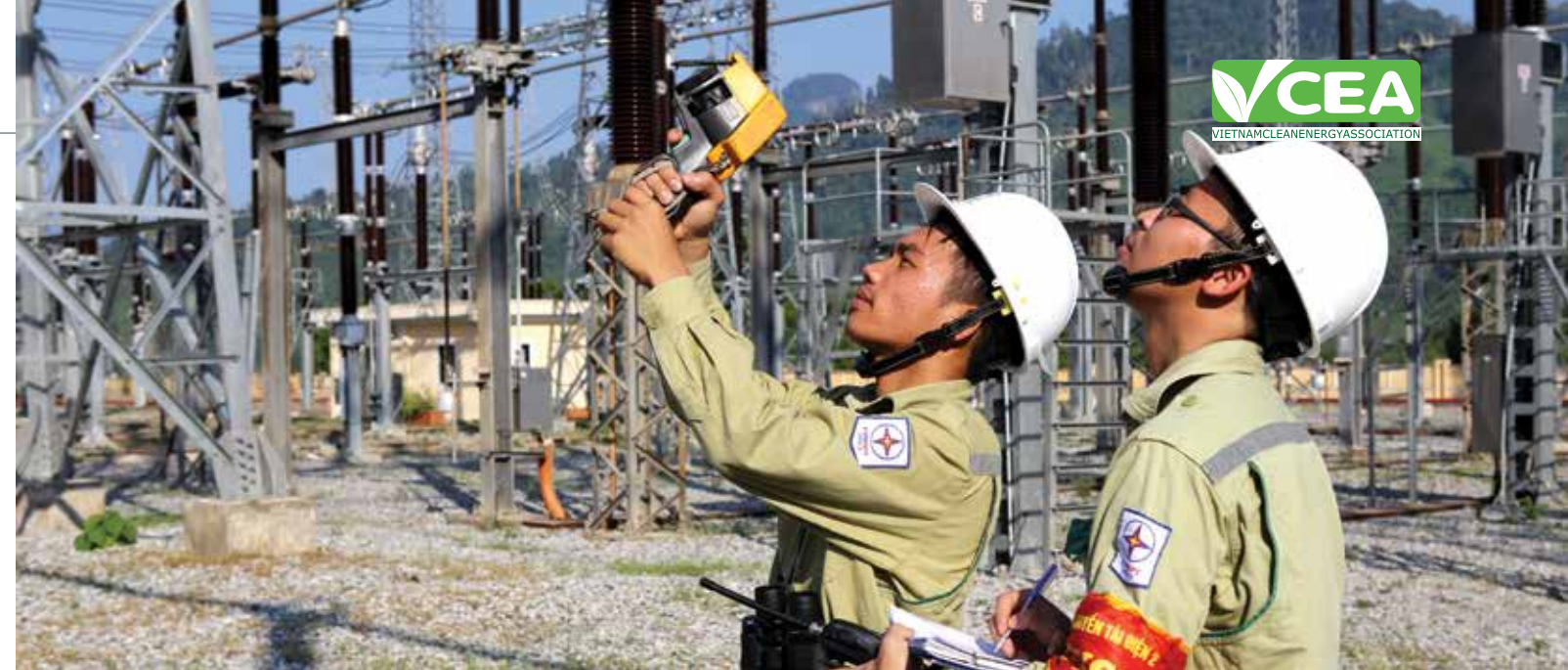
Công nhân truyền tải điện kiểm tra phát nhiệt, ngăn ngừa sự cố TBA.
