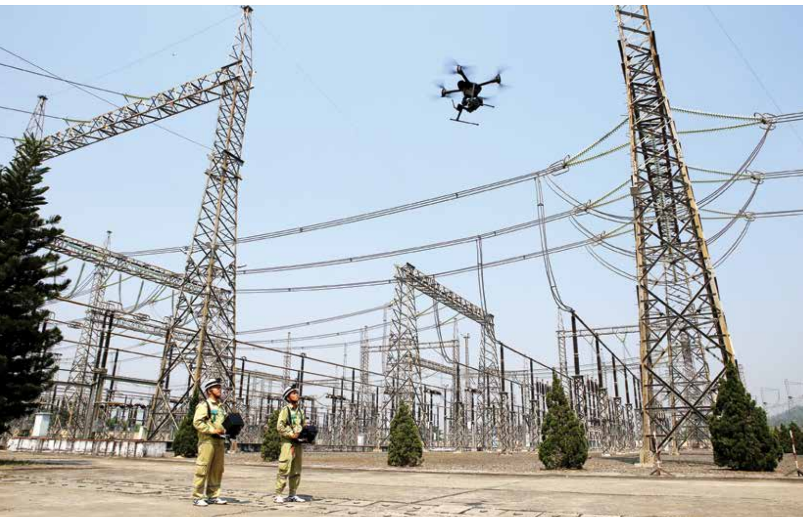
Kiểm tra đường dây 500kV bằng thiết bị bay không người lái.
