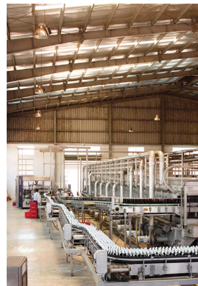
■ Dùng tấm lợp trong suốt để chiếu sáng nhà xưởng, thực hiện tiết kiệm điện ở Công ty CP Bia Sài Gòn - Miền Trung.
