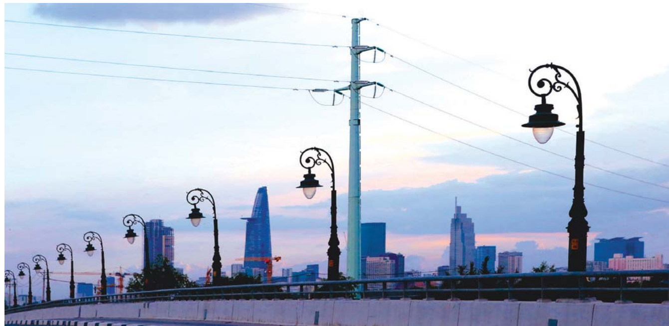
Lưới điện 110kV cấp điện cho TP. Hồ Chí Minh ■
