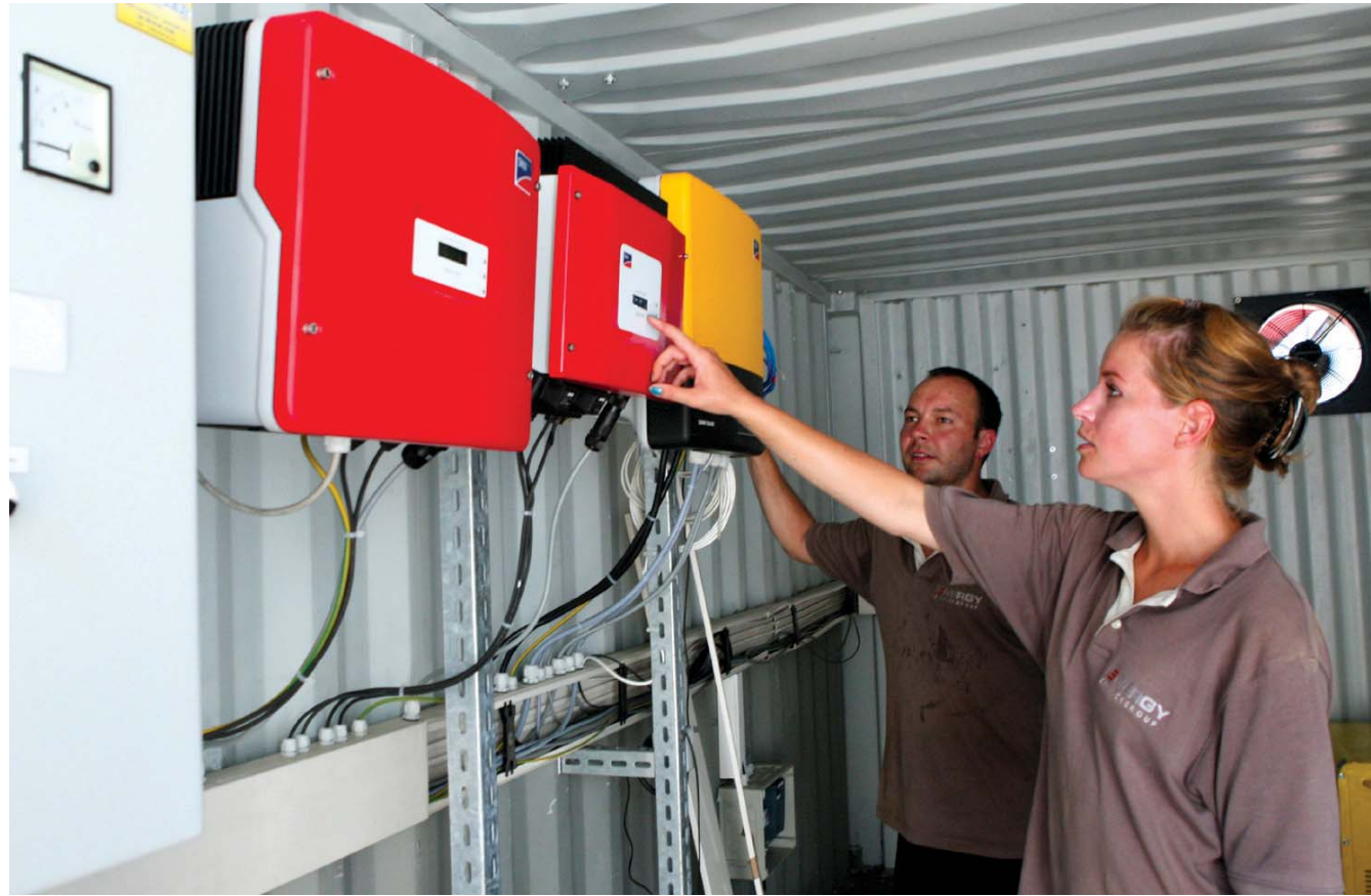
Các chuyên gia CHLB Đức và Việt Nam lắp đặt Trạm thí nghiệm đo gió và bức xạ mặt trời tìm hướng phát nguồn điện trên đảo Cù Lao Chàm
