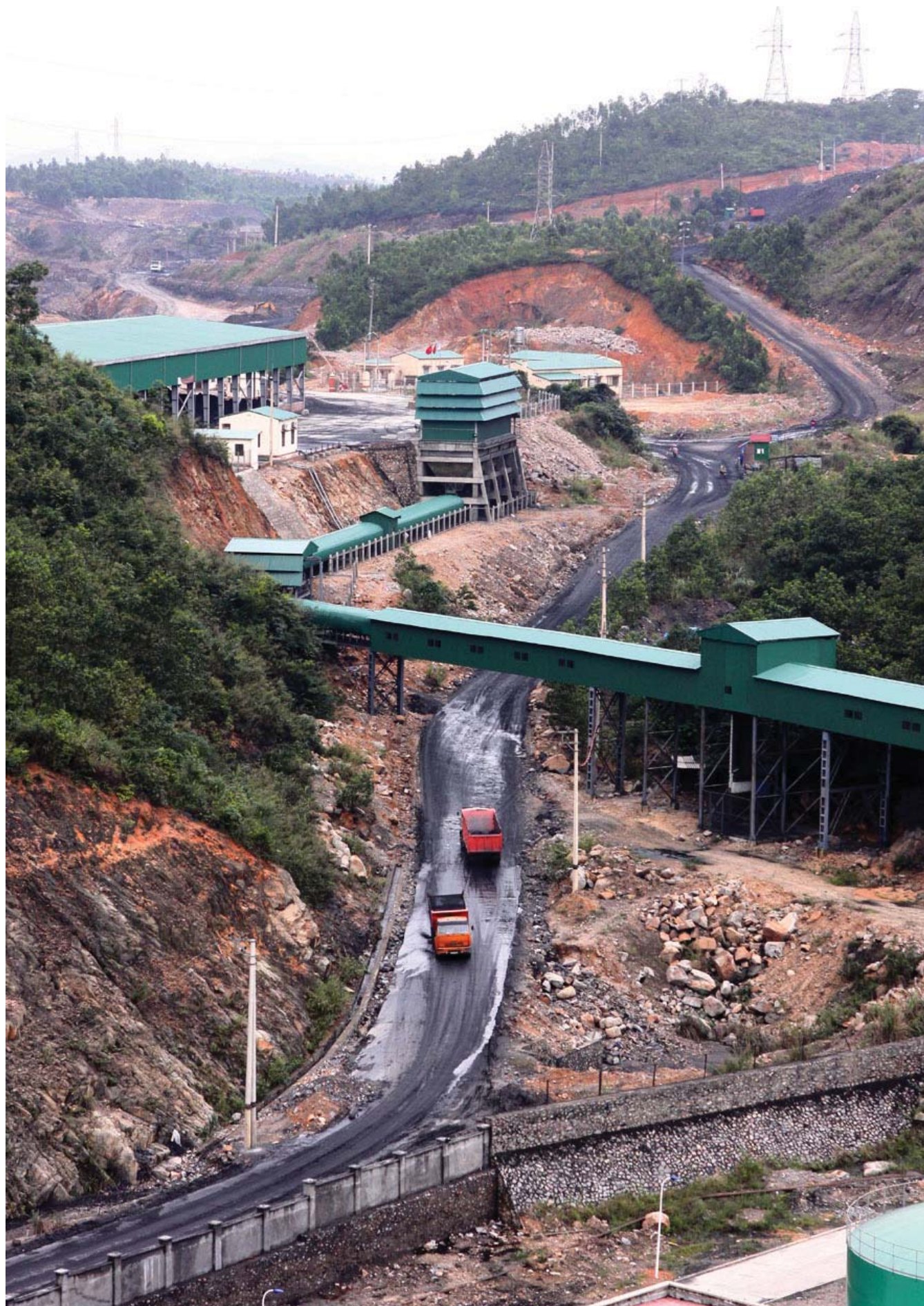
Hệ thống băng tải than cung cấp cho Nhiệt điện Quảng Ninh ■
