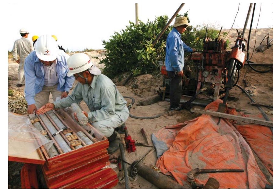
Nhà thầu JAPC (Nhật Bản) đã cơ bản hoàn thành khoan thăm dò, khảo sát thực địa Nhà máy điện hạt nhân Ninh Thuận 2
