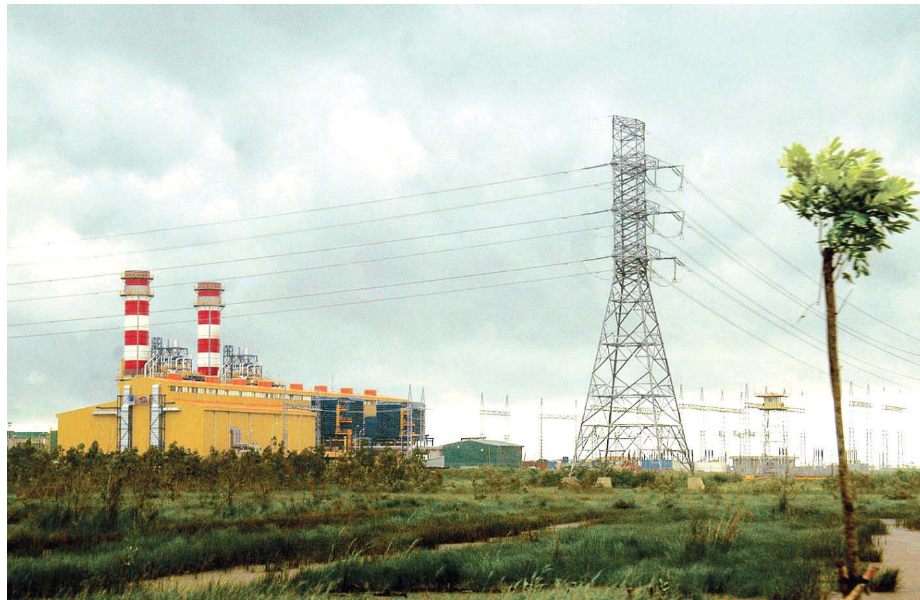
■ Nhà máy Nhiệt điện Cà Mau 2 (thuộc dự án Cụm Khí- Điện-Đạm Cà Mau do Tập đoàn Dầu khí Quốc gia Việt Nam làm chủ đầu tư)
