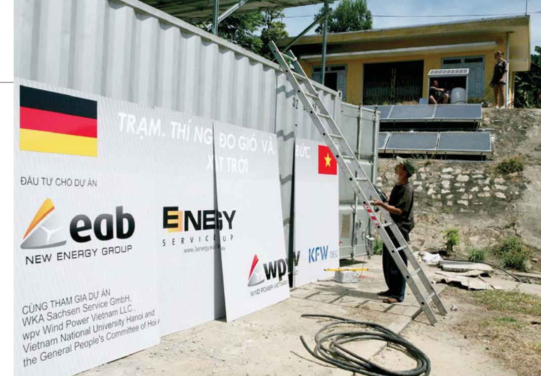
Lắp đặt hệ thống điện gió trên đảo Cù Lao Chàm (Quảng Nam)
